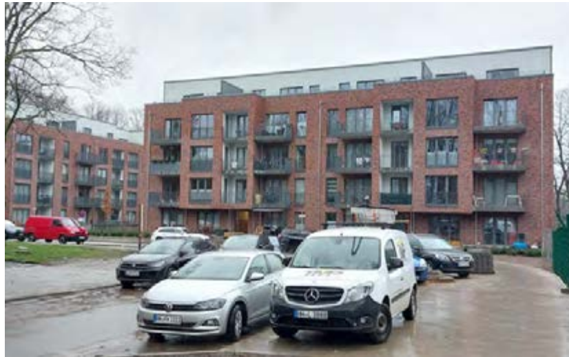
August-Krogmann-Straße 100, SAGA Typenbau Quelle: Bezirksamt Wandsbek
