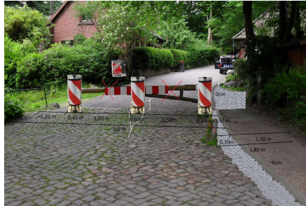
Bild 9: Nördlicher Anschluss – 2. Absperrvariante (Quelle: Eigene Aufnahme 2017, bearbeitet)
