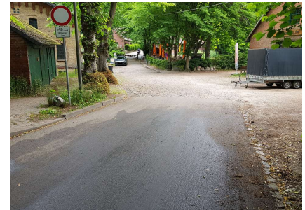
Abbildung 4: Bestand - Südlicher Anschluss (Quelle: Eigene Aufnahme 2022)
