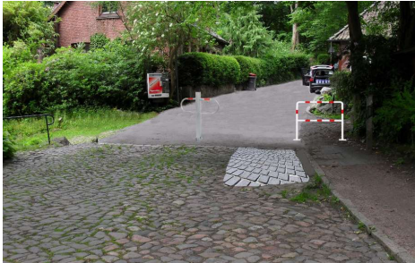
Bild 8: Nördlicher Anschluss – 1. Absperrvariante (Quelle: Eigene Aufnahme 2017, bearbeitet)
