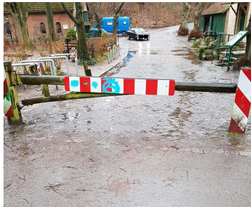
Abbildung 3: Bestand - Schranke im nördlichen Anschluss (Quelle: Eigene Aufnahme 2022)
