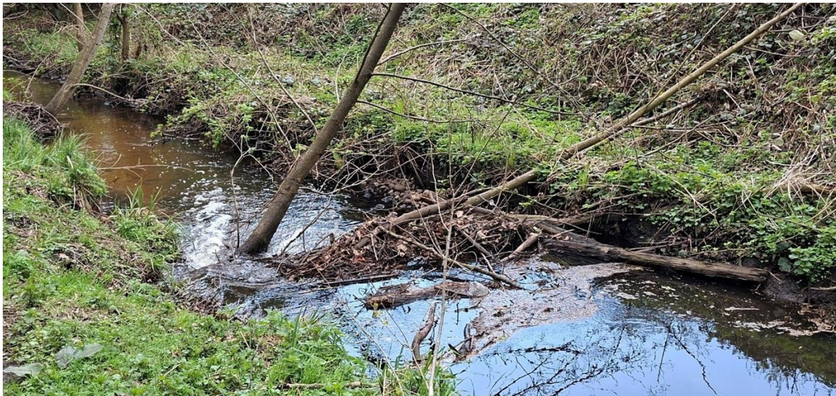
Abbildung 42: Verklausung an der Tarpenbek; Quelle: (Bezirksamt Hamburg-Nord)
