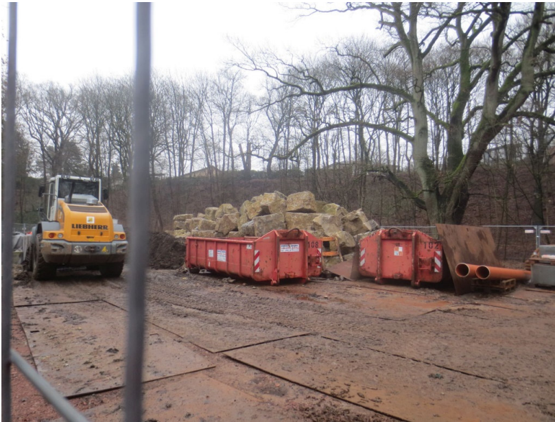
Alsterwanderweg, Position Frühblüherfläche Nr. 39 (Abschnitt Nord), Baustelle „Neue Fischtreppe an der Poppenbütteler Schleuse“, Datum 10.1.22 = Endphase mit wenig (!) Baumaterial-Überdeckung und Fahrzeug-Lagerung
