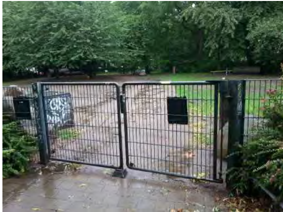
Bild 3: Ansicht Eingangsbereich Südwestseite
