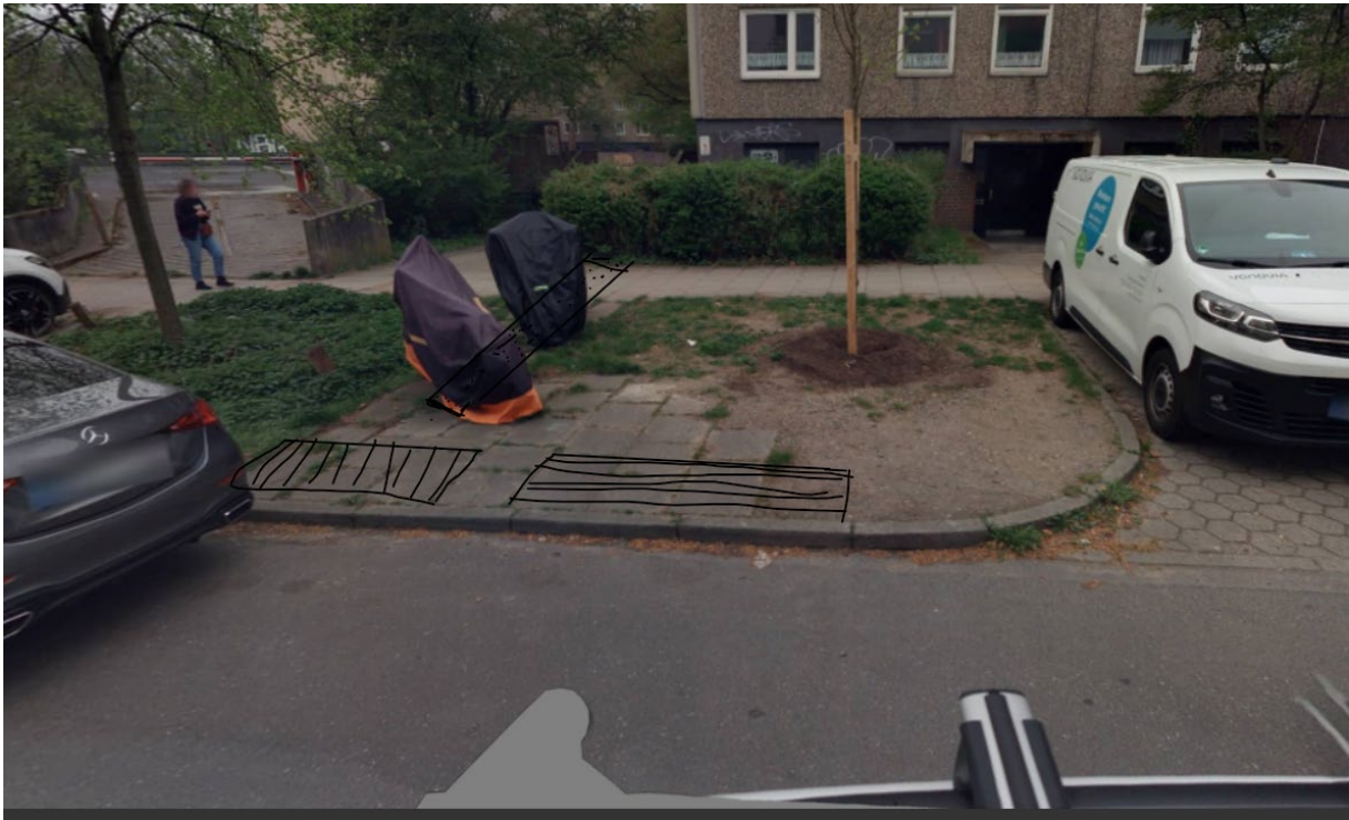
Fritz-Flinte-Ring 1 West - Blindenleitsystem, 3 cm-Bord mit 2,5cm Rundbord (Skizze folgt), Baumscheibe? Umlaufgitter entfernen
