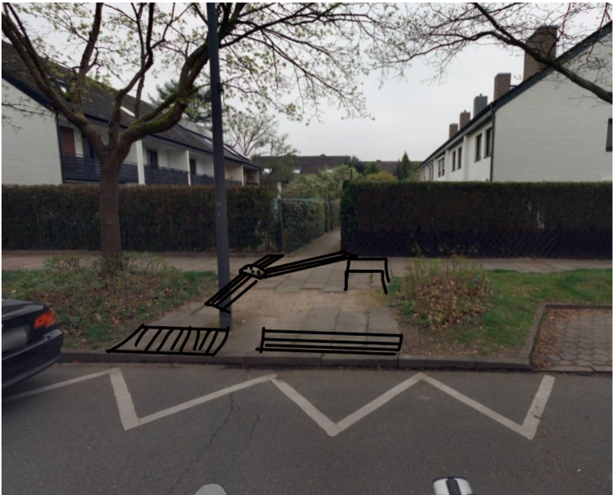
ggü. Borchertring 35 - Blindenleitsystem, 0-6 cm-Absenkung, Umlaufsperrn entfernen, Fahrradabstellbügel
