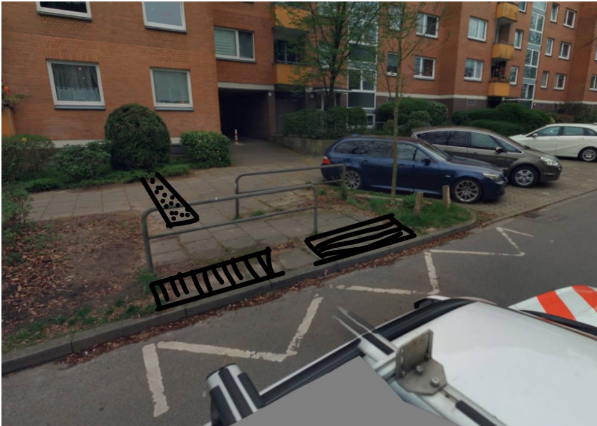
Erich-Ziegel-Ring 11 West - Blindenleitsystem, , 0-6 cm-Absenkung, Fahrradabstellbügel?, Umlaufsperrn entfernen, vor Ort anschauen
