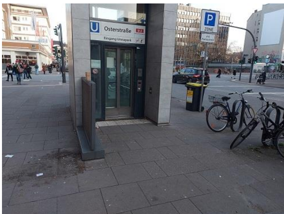
Abbildung 9 - Fahrstuhleingang Heußweg (Haspa)
