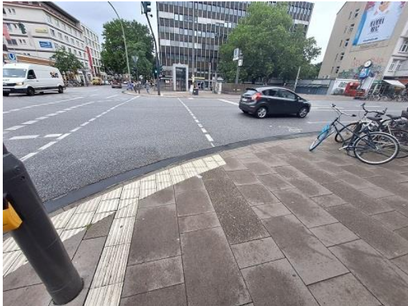
Abbildung 4 - Ampelquerung Karstadt in Richtung Iduna-Hochhaus
