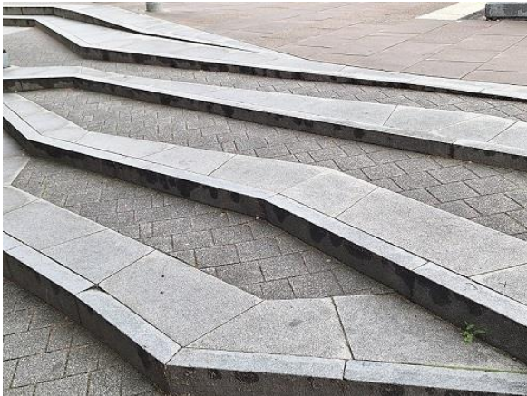
Abbildung 17 - Treppenanlage am Fanny-Mendelssohn-Platz
