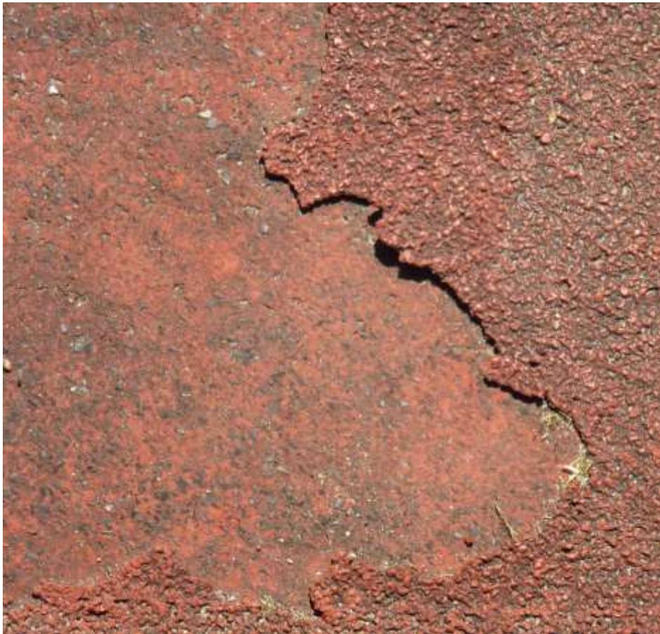
Tab. 3 Substanzverlust der Kunststoffbeläge
