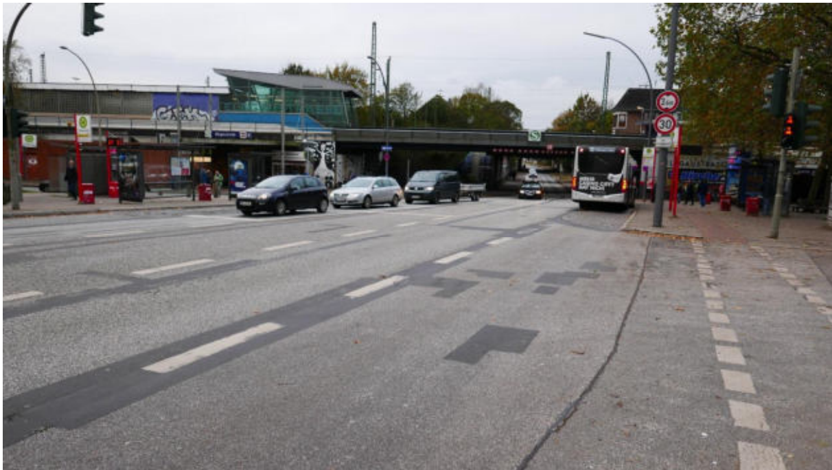
Abbildung 4: Schadensbild an der S-Bahn- und Bushaltestelle Elbgaustraße; Quelle: BPR
