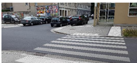
Abb. 15: Barrierefreie Fahrbahnquerung mit Tief- und Nullbord
