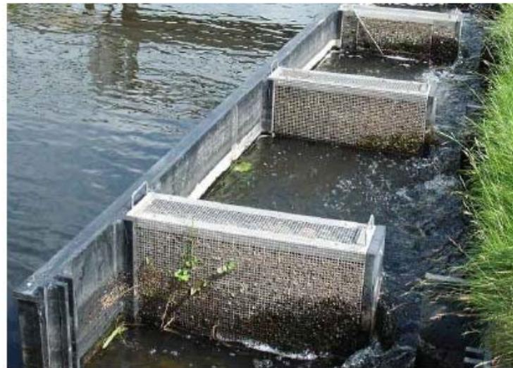
Einengungen im Fischaufstieg sorgen für die richtige Wasserströmung und bauen den Höheunterschied zwischen Ober- und Unterwasser kontinuierlich ab. Eine Besonderheit sind die substratgefüllten Strömunglenker, die zusätzlich den Aufstieg von Kleinlebewesen verbessern.
