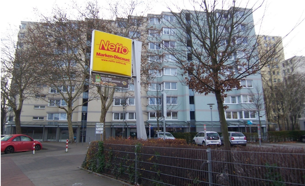
Abb. 12: Ladenzeile und Parkplatz am Lüdersring
