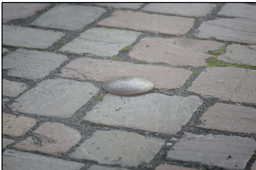
Stahlnägel als Markierung der Parkstände
