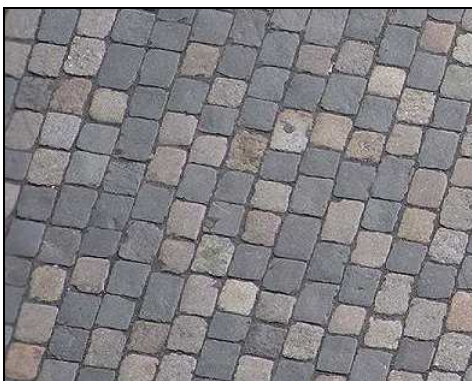
Großsteinpflaster Granit in Reihe verlegt, rot-bunte Mischung
