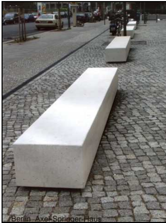
Sitzelement aus Sichtbeton
