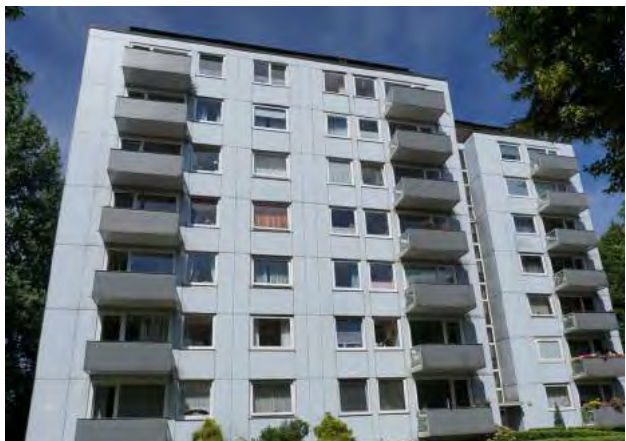
Grünebergstraße | Punkthochhaus mit Vorhangfassade
