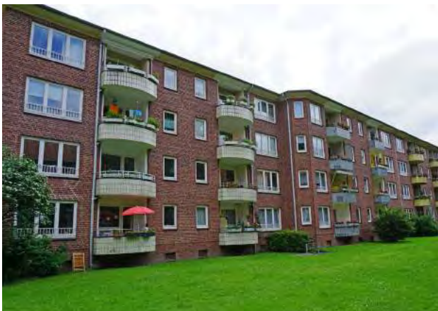
Hohenzollernring | Gebäuderückseite im Röhrig-Block
