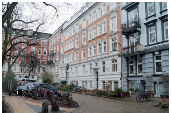
Abb. 23: Paulsenplatz | Durchlaufendes Gesims oberhalb des EG
