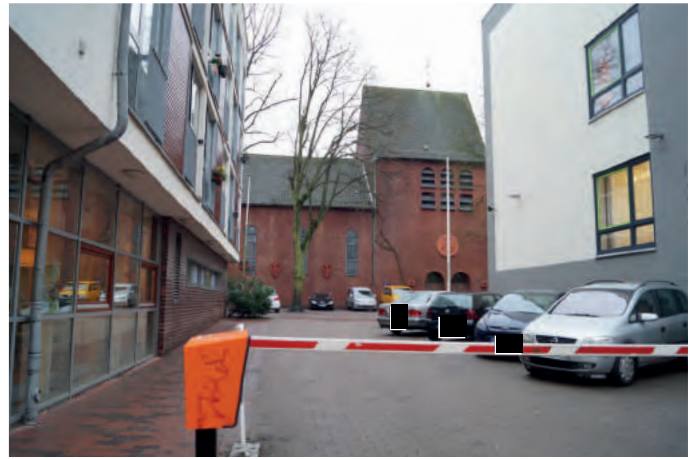
Abb. 102: Kirche St. Theresien | Stellplatzanlage
