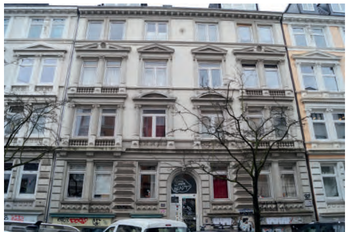
Abb. 33: Bernstorffstraße - Nord | Durchlaufendes Gesims oberhalb des EG
