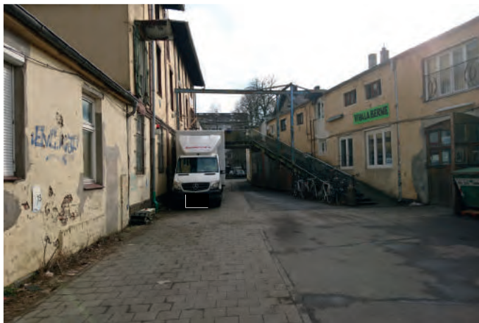
Abb. 121: Gewerbehof | Innenliegende Erschließungsgasse
