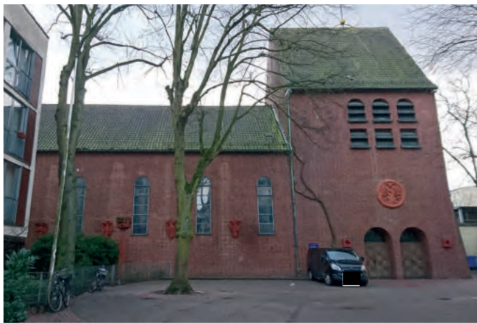
Abb. 101: Kirche St. Theresien | Kirche im rückwärtigen Bereich
