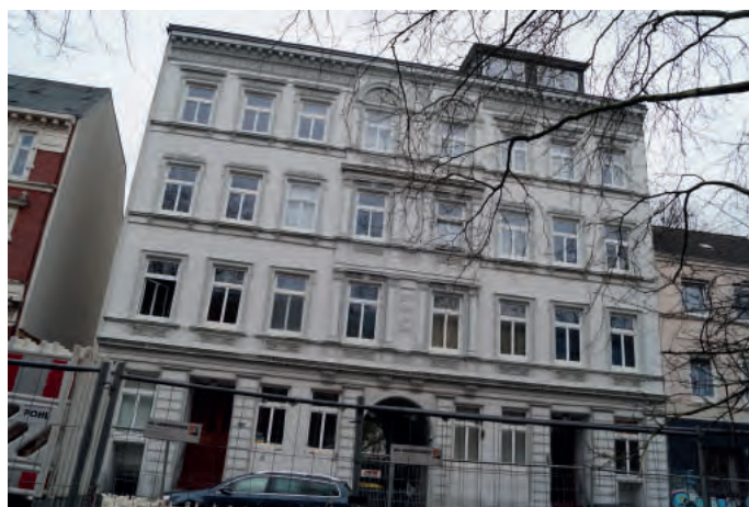
Abb. 41: Thadenstraße | typische Fassadengliederung
