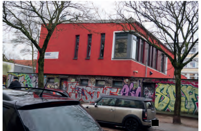
Abb. 112: Ganztagsschule Bernstorffstraße | Wirkung im Straßenbild
