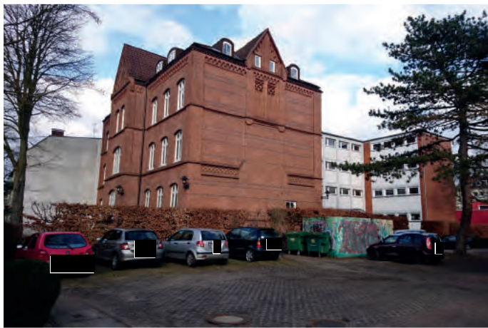
Abb. 111: Ganztagsschule Bernstorffstraße | Hauptbaukörper von 1930
