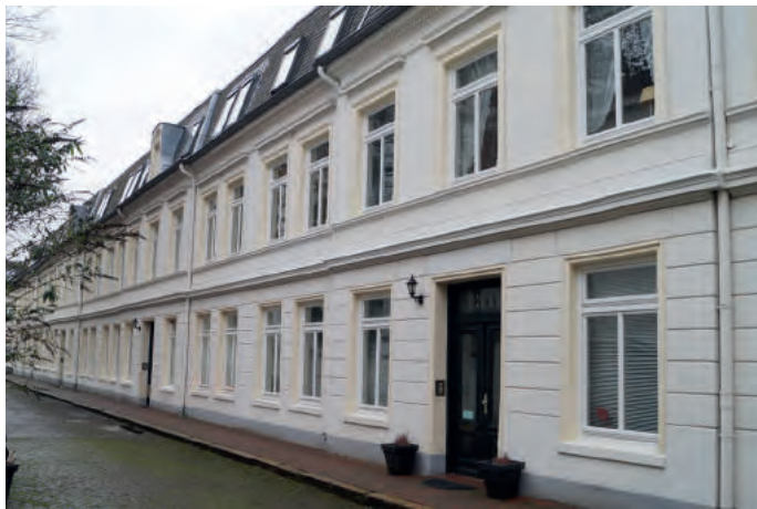
Abb. 71: Levy's Passage | typische Fassadengliederung
