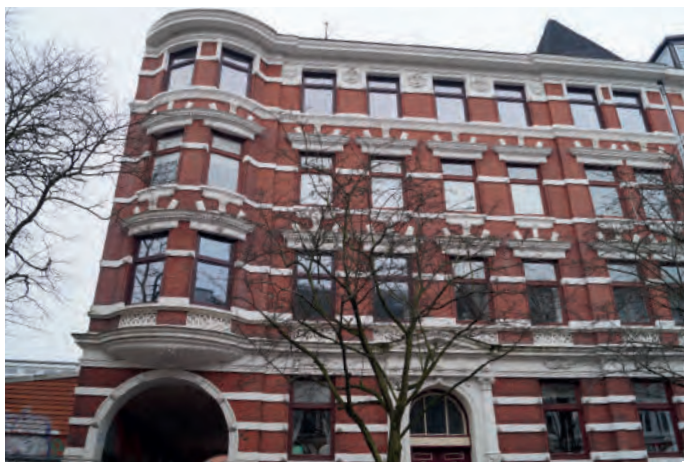
Abb. 31: Bernstorffstraße - Nord | typische Fassadengliederung
