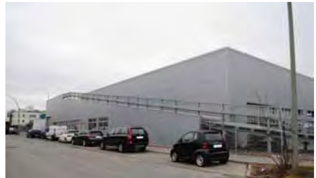
83 Flächeneffizient durch Verlagerung von Stellplätzen auf die Dachfläche
