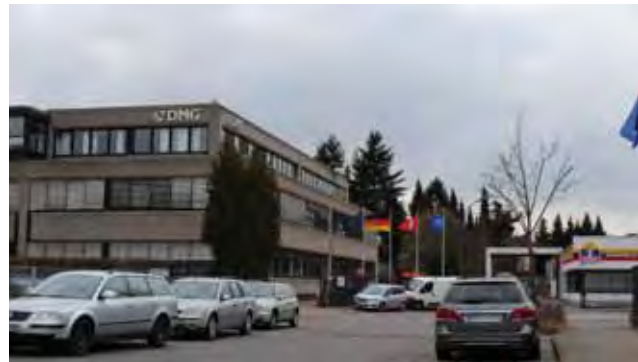
107 Büro- und Verwaltungsgebäude am Stich der Elbgaustraße
