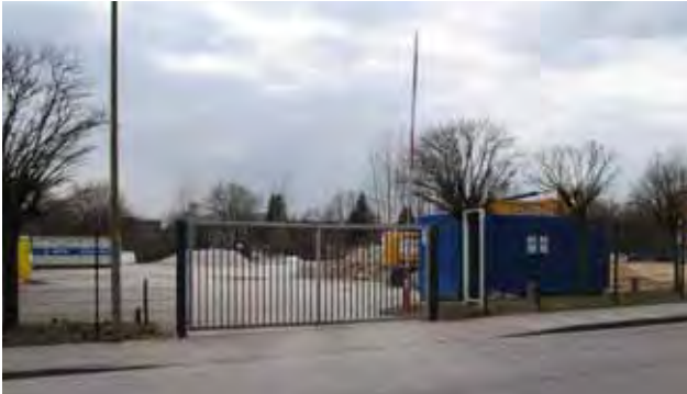
102 Abbrucharbeiten am Hellgrundweg
