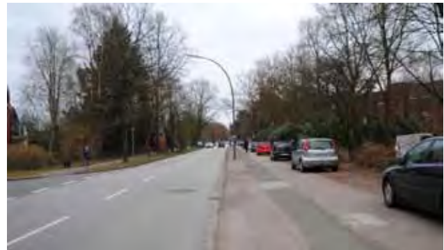
135 Frequentierte Straße mit Modernisierungsbedarf (Rissener Landstraße)
