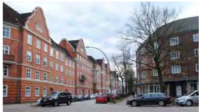
77 Das vom Gewerbegebiet umschlossene Wohngebiet (Ruhrstr./Schützenstr.)
