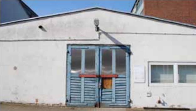
91 Nachverdichtungspotenzial in eingeschossiger Lagerhallen
