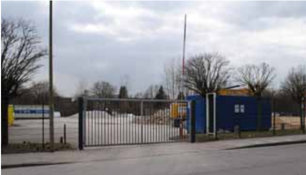
103 Abbrucharbeiten am Hellgrundweg
