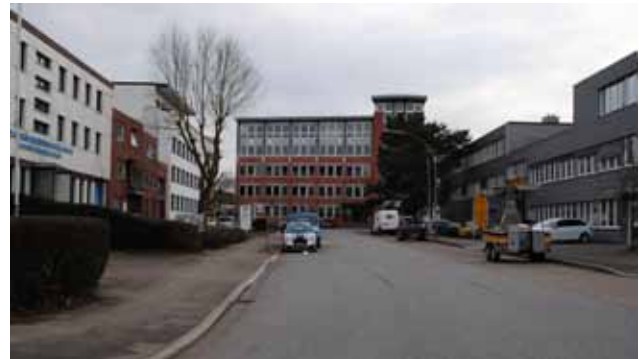
117 Ausreichende Dimensionierung der Ringstraße (Brandstücken)
