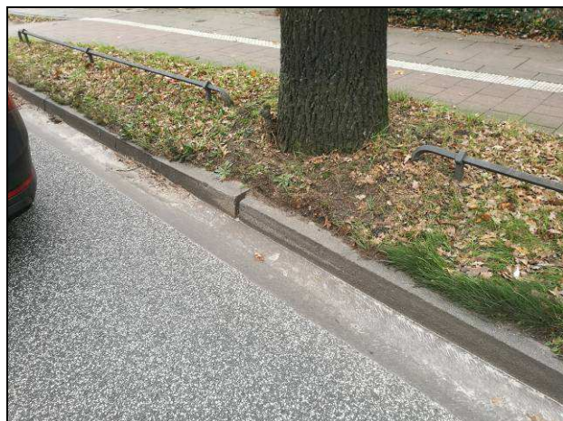
Abb. 22+23: Belagsanhebungen im Straßenraum aufgrund zu gering bemessener Baumstandorte im Rugenbarg
