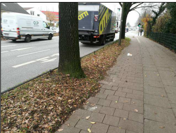
Abb. 22+23: Belagsanhebungen im Straßenraum aufgrund zu gering bemessener Baumstandorte im Rugenbarg
