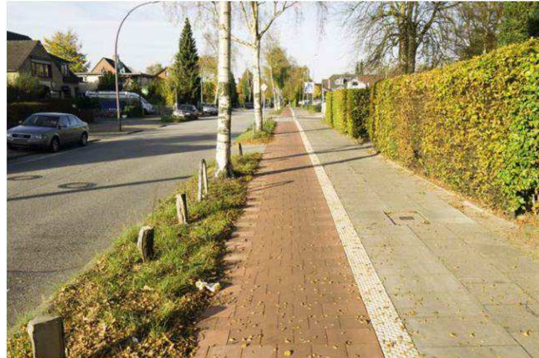
Bild 107: Bekassinenau, Ausbau und Verbreiterung des Radwegs
