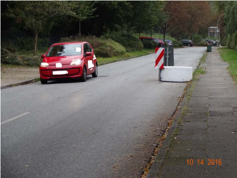
Fotos Betonring Fabriciusstraße (Urheber: Sandro Kappe)
