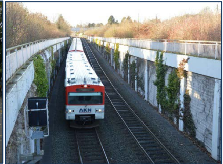
Abb. 17: AKN-Trasse (Fotos: steg)
