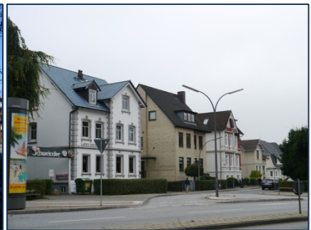
Abb. 6: Nebenbahnstraße (Fotos: steg)
