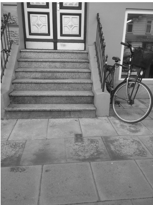
Osterstr.19, nach Umbau
