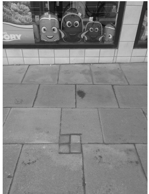
Schulweg 36, nach Umbau
