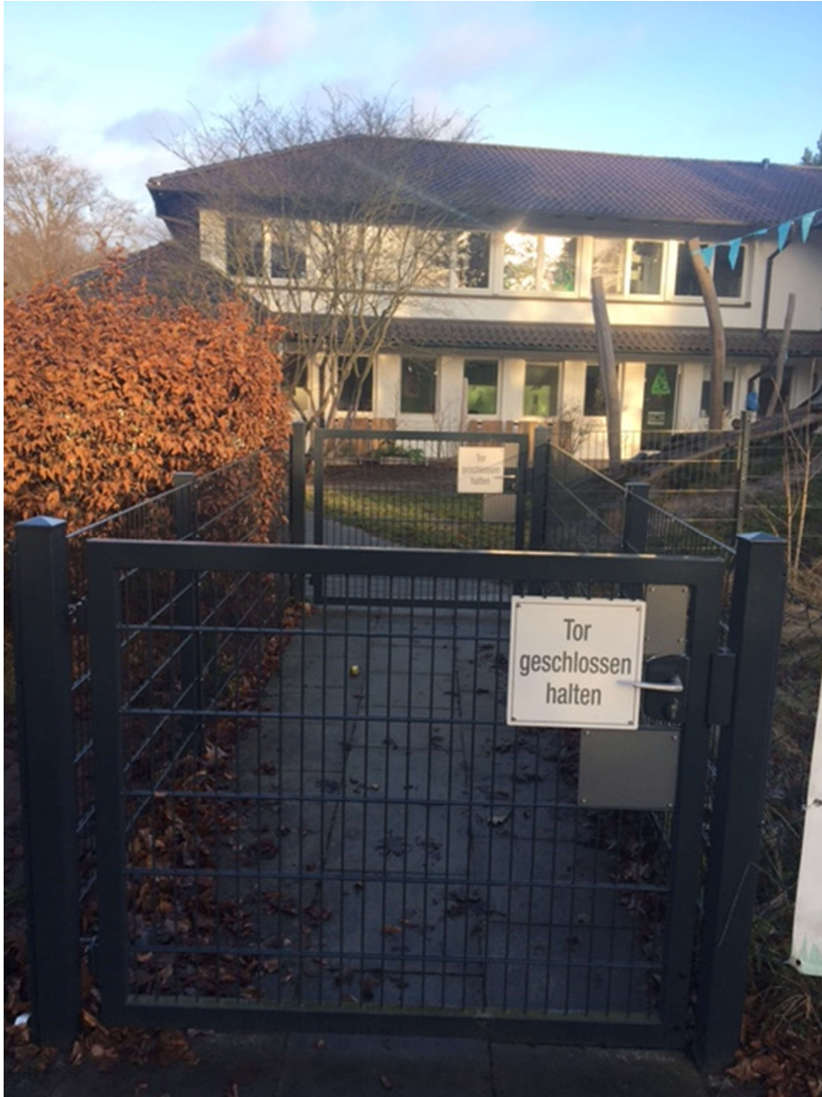
Sicherung Haupteingang Kita
