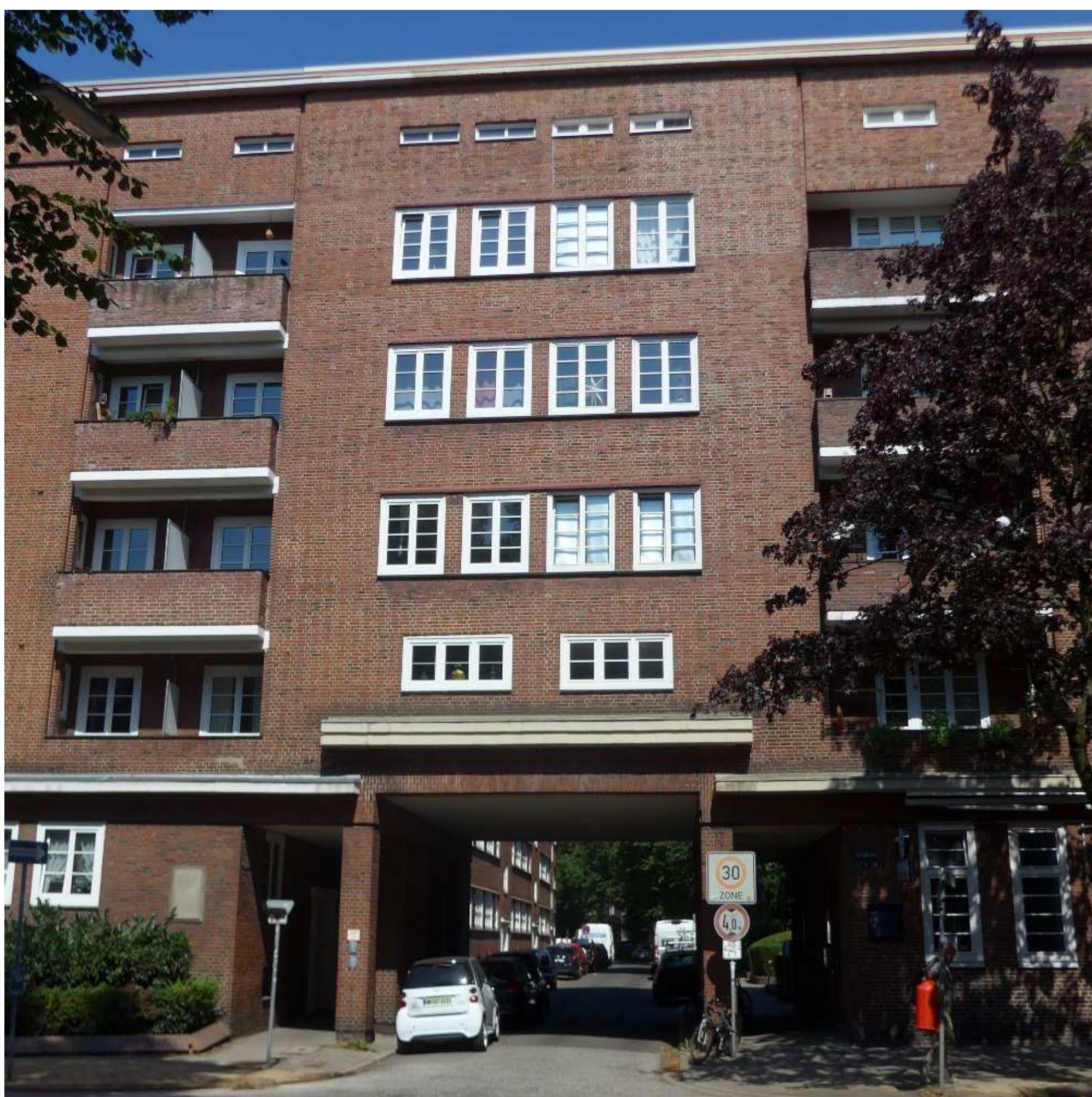
Überbauung an der Jarrestraße/ Jean-Paul-Weg – Eingang in das Quartier
