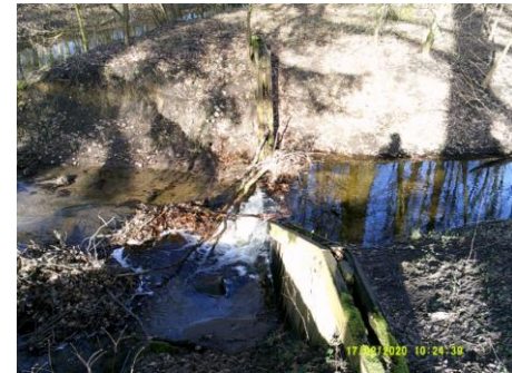
Sohlenschwelle Berner Au
