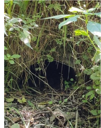
Durchlass Berner Au (7+700.000 Kilometrierung)
