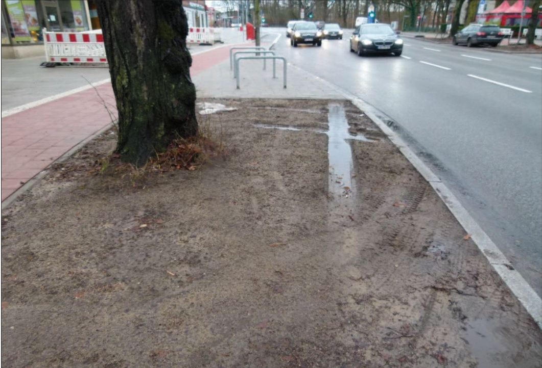
Bild 4 Beschädigungen der Baumscheiben
