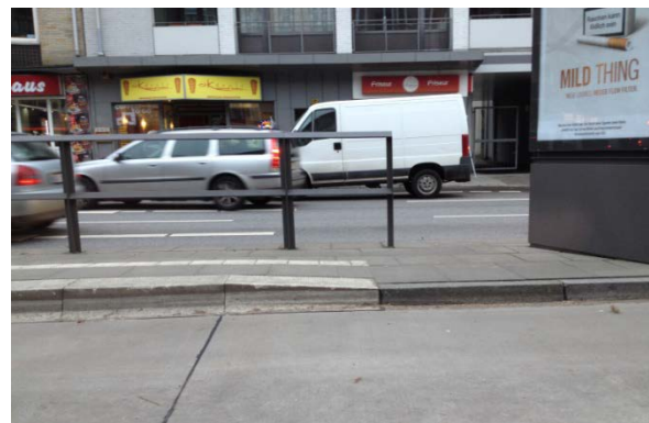
Abb. 9: Positivbeispiel: Bauausführung mit Übergangsstein, Hochbahn 2015.
