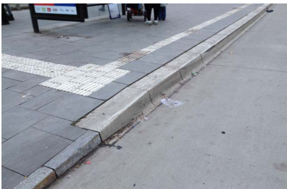
Abb. 9: Positivbeispiel: Bauausführung mit Übergangsstein, Hochbahn 2015.
