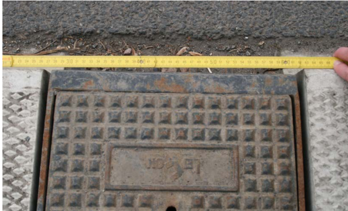
Abb. 11: Negativbeispiel Entwässerungselement, Wiesenhütter 2015.
