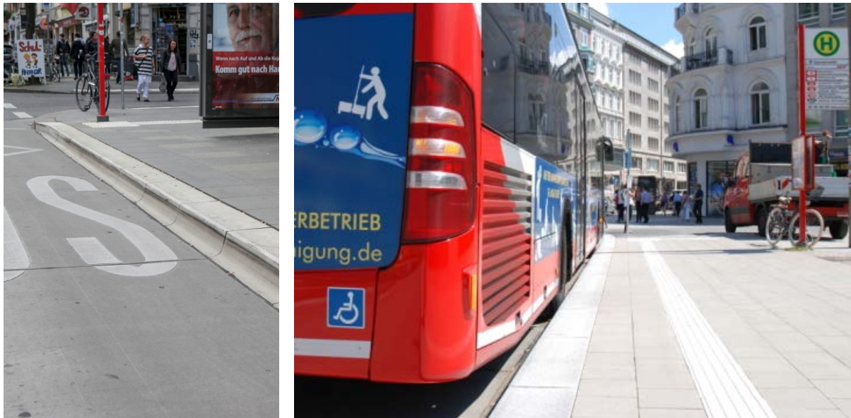
Abb. 2: Haltestelle mit Sonderbord, HVV 2015/ Hochbahn 2014.
