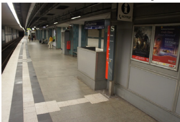
Abb.: Notruf-/Infosäule auf Mittelbahnsteig vor Wand
