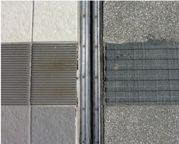
Abb. 6: U-Bahn-Haltestelle Hamburger Straße: Übergang vom Betonleitstreifen zur Kaltplastik
