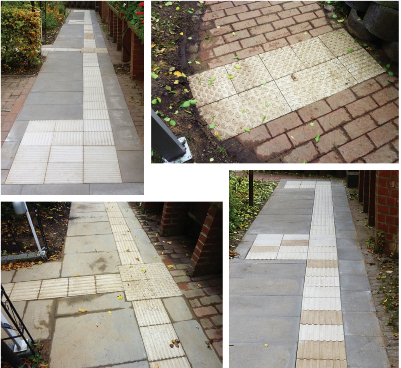
Abb. 2 bis 5: Eindrücke von der Teststrecke
