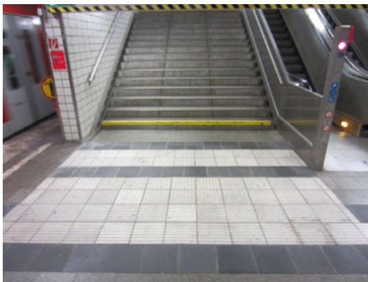
Abb.: Auffangstreifen vor Treppenantritt oben und unten
