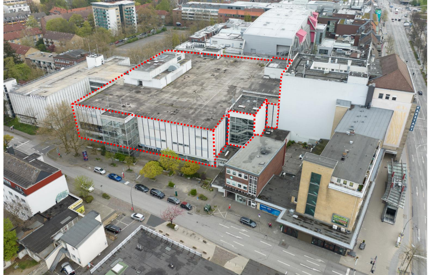
Neu: Erhalt Rohbau und Untergeschoss Karstadt-Gebäude von 1967
