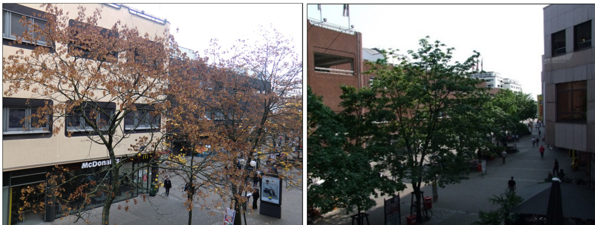
Abb. 14 und 15: (links) Neu gestaltete Südfassade des Billstedt Centers und (rechts) Südfassade des Billstedt Centers vor der Betonsanierung (Fotos © Fachamt Stadt- und Landschaftsplanung)
