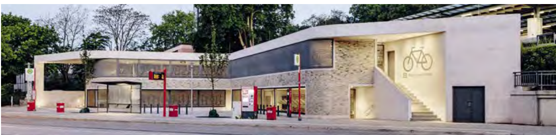
Bild 26: Fahrradparkhaus U-Station Kellinghusenstraße. © BOERNER PHOTOGRAPHER
