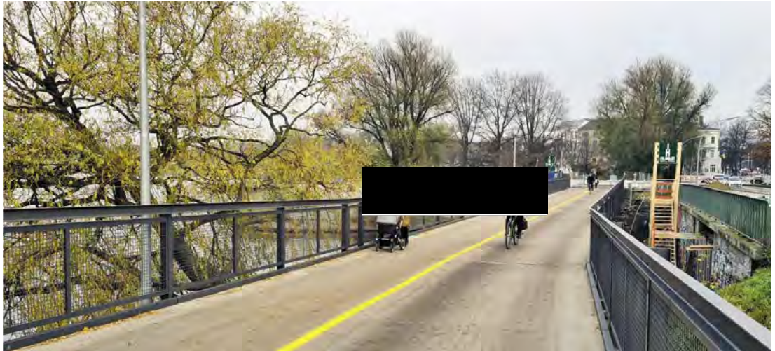
Bild 23: Behelfsbrücke Hohenfelder Bucht. © BVM
