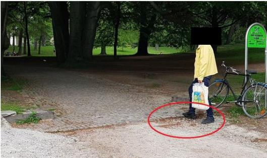
3. Im Abzweig des Binnenweges hat das Wasser sich einen eigenen Weg quer zum Abzweig gebahnt: eine Stolperfalle für Spaziergänger/Jogger und Rollifahrer. Hier sollte durch geeignete Maßnahmen das Abwasser wieder in die vorgesehene Schiene gelenkt werden.
