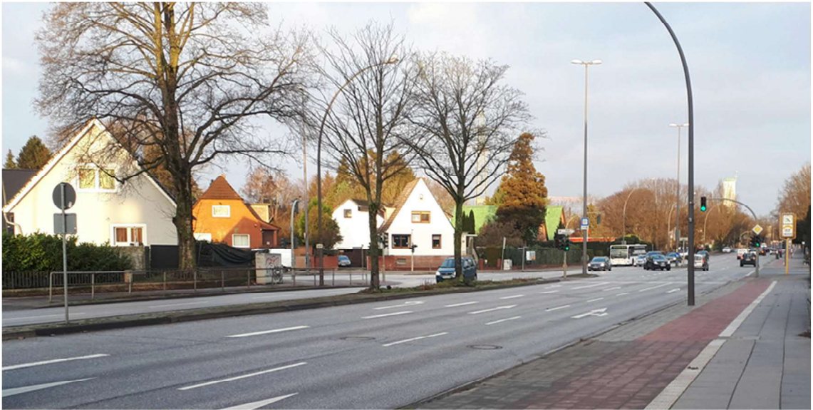
Abb. 19: Bestandsfoto Jenfelder Allee Süd - vorhandene Straßenbäume
