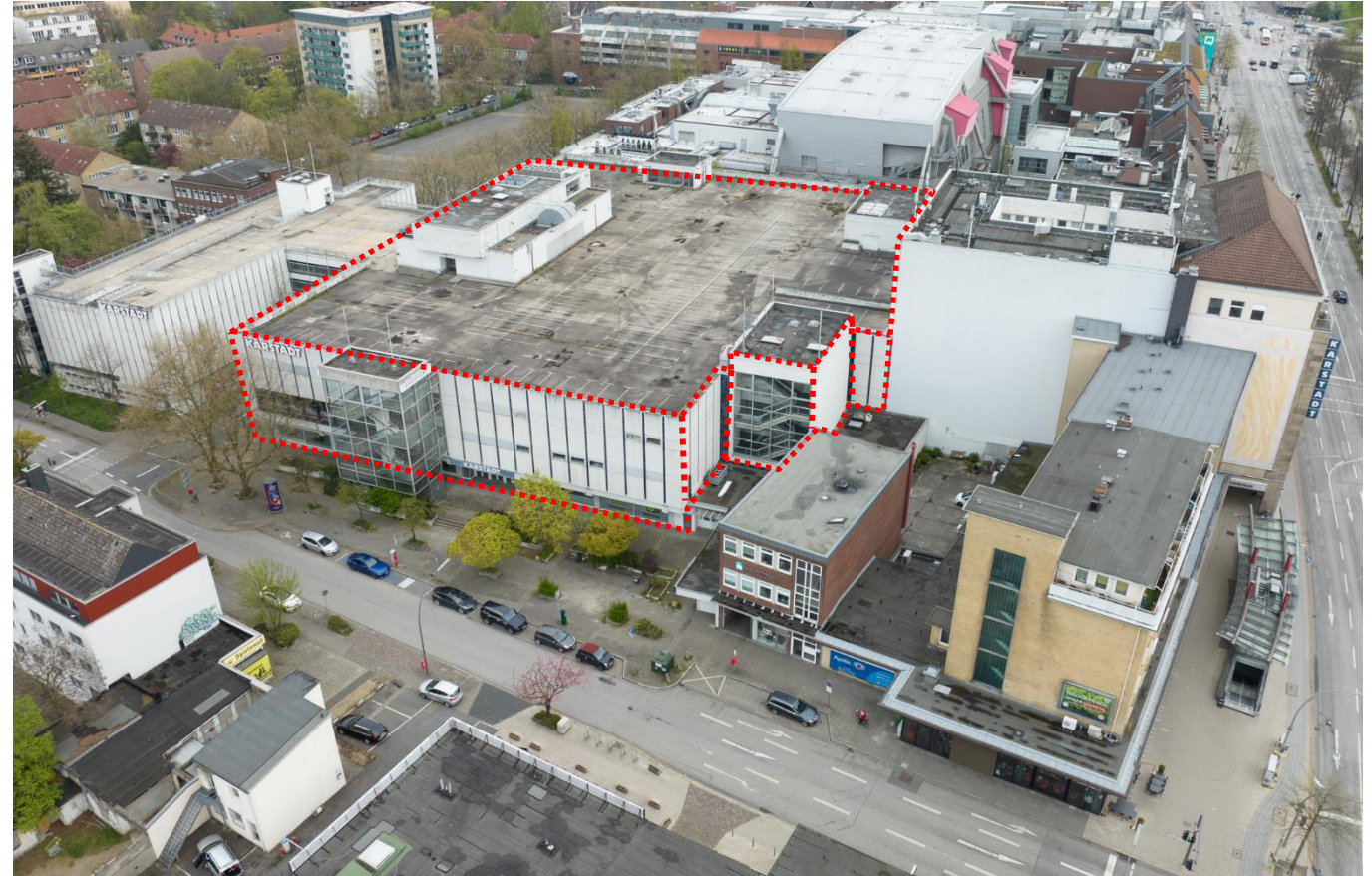
Neu: Erhalt Rohbau und Untergeschoss Karstadt-Gebäude von 1967
