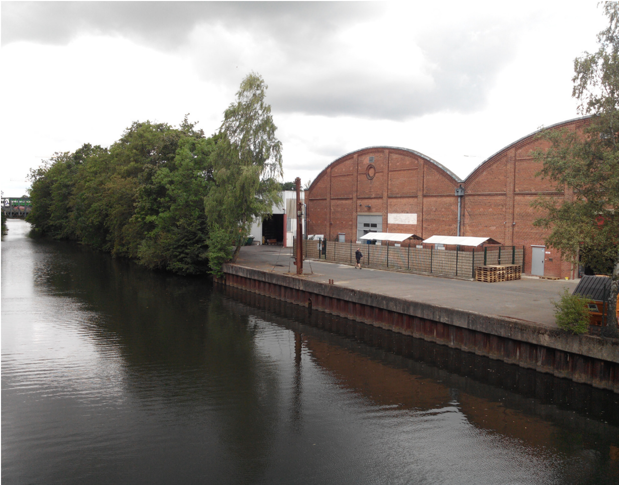
Abb. 9: Blick von der Friedrichsbrücke auf die Stuhlrohrhallen
