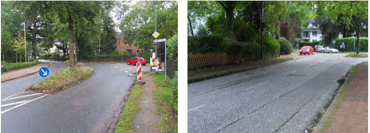
Abbildung 3 Teilbauabschnitt 5: Knotenpunkt Manteuffelstraße/Schanzkamp (Quelle: eigene Fotos)
