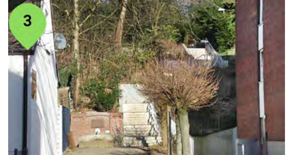
Treppenmodernisierung Holtenklinker Str.
