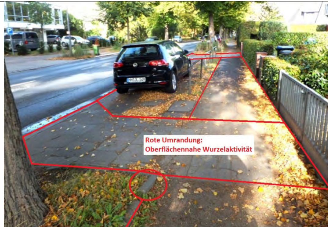
Abbildung 7: Exemplarischer Zustand der südöstlichen Nebenflächen: Linden mit Baumscheiben und Längsparken auf Baumstreifen im Verlauf vor Nr. 50-54. Alle rot umrandeten Flächen sind oberflächennah stark durchwurzelt, hier scheiden Regelbauweisen aus.
