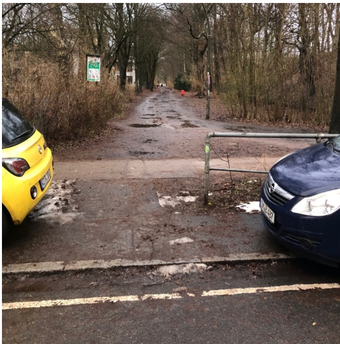
Abbildung 6: Parksituation östliche Seite der Dieselstraße. Das Parken ist an dieser Stelle zurzeit erlaubt. (siehe auch Abb. 4). Ein Halteverbot und die Verkürzung des Fußgängerschutzgitters zwischen Fußweg und Straße würden den Weg freigeben.
