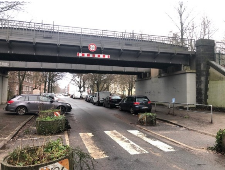
Abbildung 8: Fußgängerüberweg Dieselstraße südlich der U-Bahn
