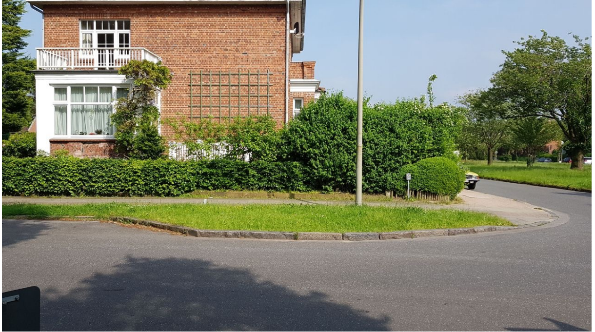
Die Sicht auf das Gebäude Beim Schäferhof 43
