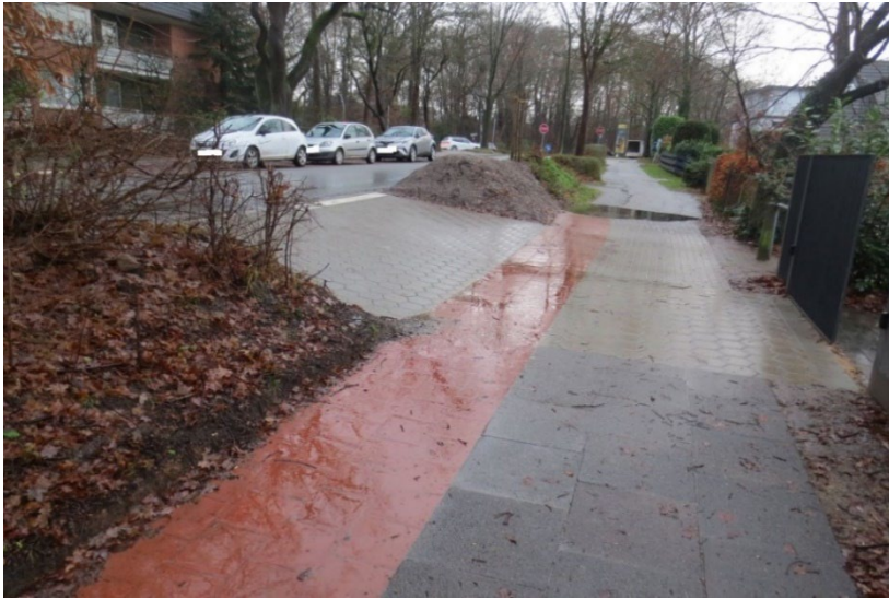
Wiederhergestellter öffentlicher Raum nach Baumaßnahme auf Privatgrund (Saseler Mühlenweg 5)
