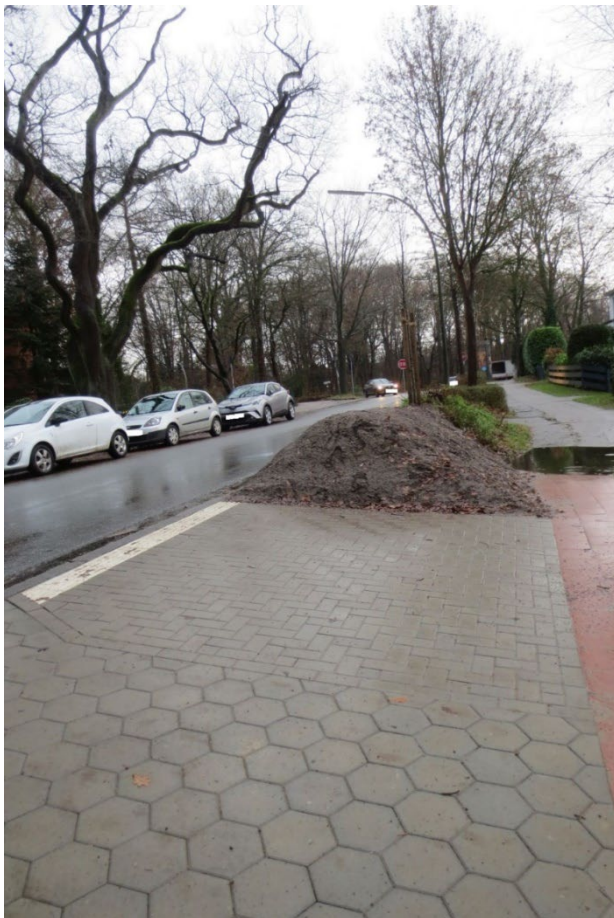
Neuer Erdwall „Straßenknick“, Überfahrt (Wabensteine), öffentlicher Übergang in Geh-/Radweg Apothekegang mit taktilen Elementen
