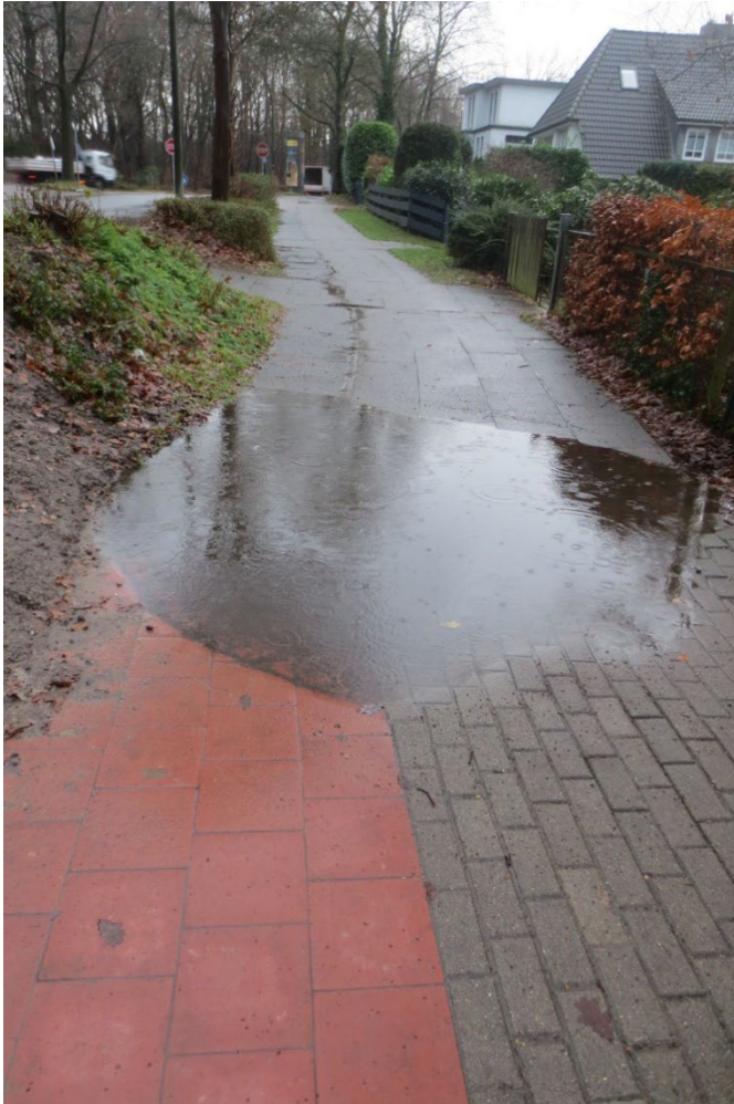
Pfütze über neuer Wegefläche und untermaßiger überwachsener Radweg im Wege-Altbestand
