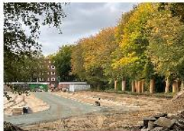
Während der Baumaßnahme für die Sportanlage in Dulsberg.
