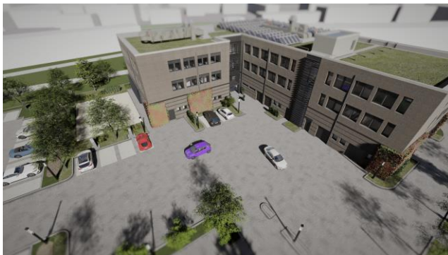
Quelle: Neubau LED72, Stromnetz Hamburg
