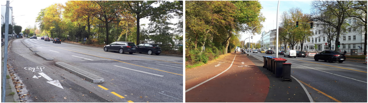
Abbildung 2: Protected Bike Lane (Gebäudeseite) und Zweirichtungsradweg (Alsterseite) in der Straße An der Alster
