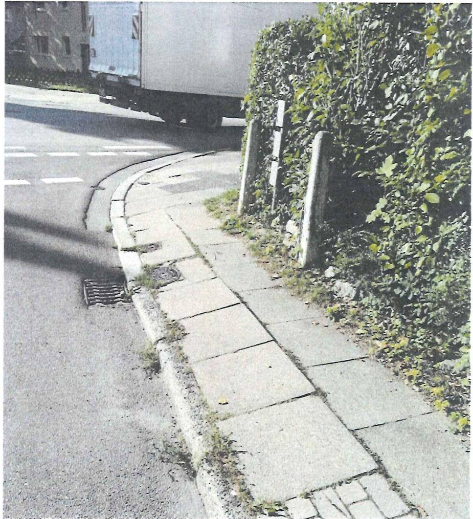
Durch den jahrelangen Busverkehr haben die Gehwege massiv gelitten und sich schräg abgesenkt, was für Rollatoren, Kinderwagen und Kinderfahrräder bzw. Roller zum Sicherheitsrisiko wird.
