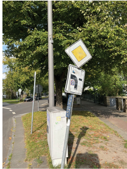
schiefes, verklebtes und von der Straße abgewandtes Vorfahrtsschild
