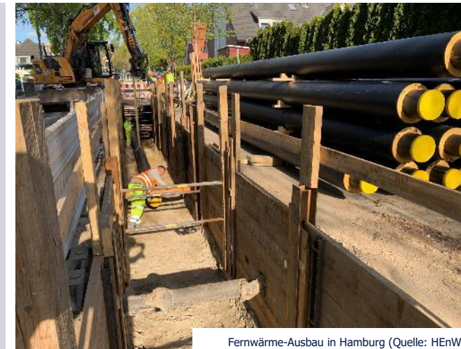
Fernwärme-Ausbau in Hamburg (Quelle: HEnW)
