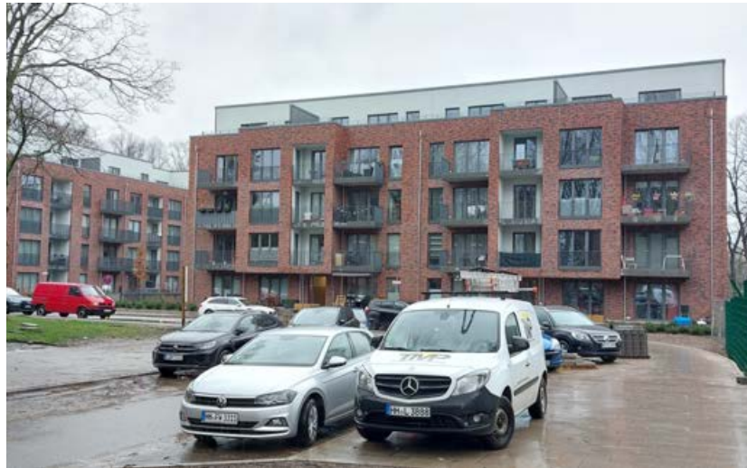
August-Krogmann-Straße 100, SAGA Typenbau Quelle: Bezirksamt Wandsbek
