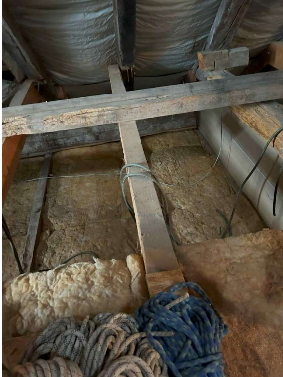
Decke über EG ist bereits gedämmt
