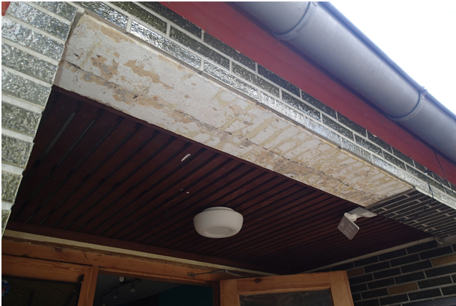
Bild 1 : Gelöste Riemchen am Sturz
