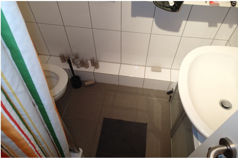
Bild 12 : Bad im Obergeschoss
