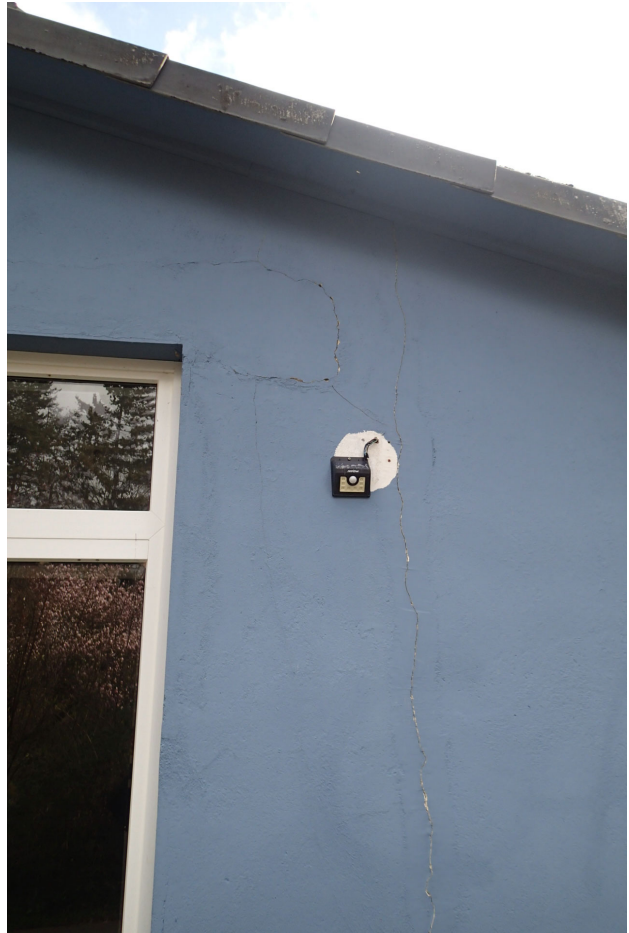
Bild 7 : Riss auf der Westwand
